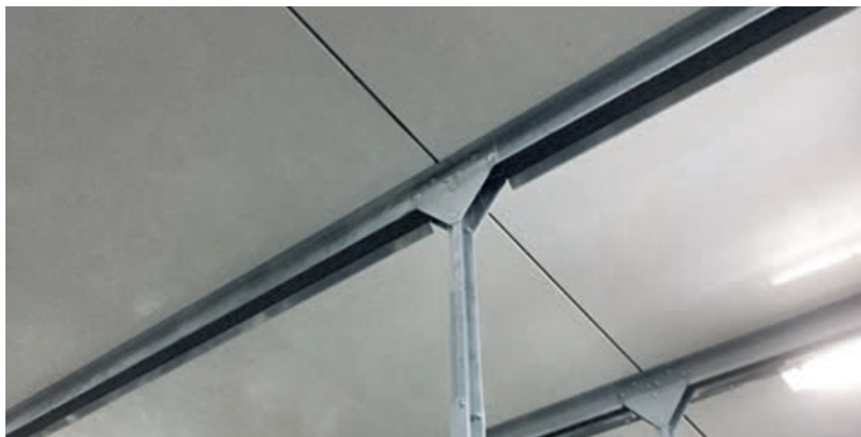
Hladký, bílý povrch plastových desek umožňuje plynulý průtok vzduchu skrz stáj bez jakýchkoli překážek a rovněž projasňuje spodní patro
